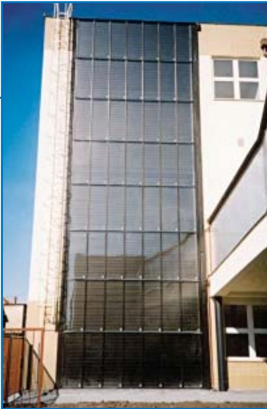
Demonstration plant in Břeclav
